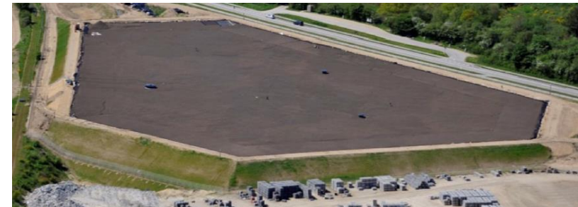
Quelle: Referenzprojekt für norddeutsche Großstadt Foto: Saisonaler Wärmespeicher Vojens – Arcon Sunmark
